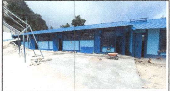
Foto 10: Sustitución de piso de tierra por torta de cemento, un total de 60 M2.
