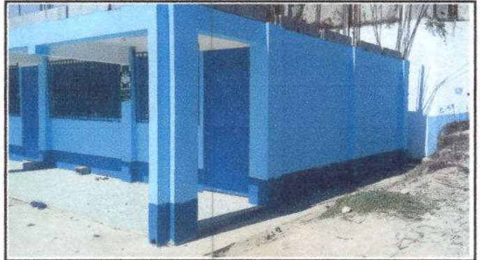
Foto 8: Pintura en muros interiores y exteriores, un total de 500 M2
