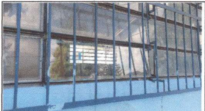
Foto 4: Sustitución de vidrios, un total de 28 unidades
