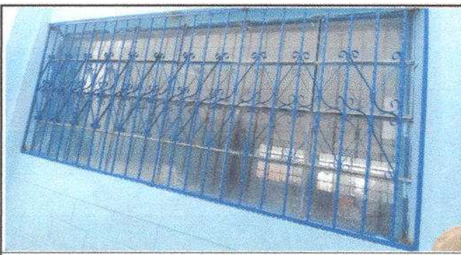
Foto 5: Sustitución de balcones de metal, un total de 15 M2.
