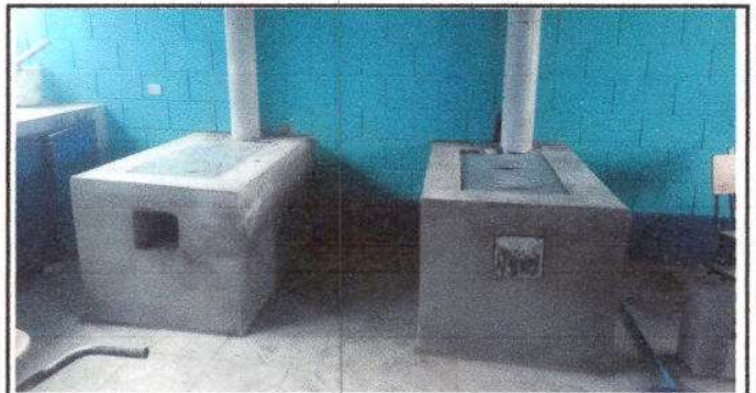
Foto 12: Sustitución de estufa rural, un total de 2 unidades.
