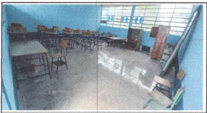
Foto 6: Sustitución de piso de cemento por piso cerámico, un total de 95 M2.
