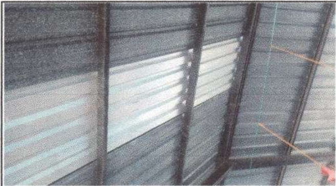
Foto1: Sustitución de lámina, por lámina troquelada aluzic calibre 26, un total de 12 M2.
