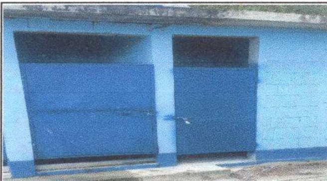
Foto 3: Mantenimiento a estructura, total 1 puerta.
