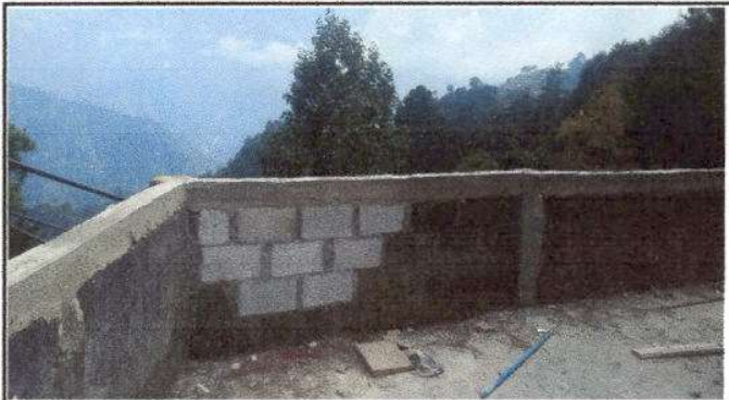
Foto 9: Reparación de muro perimetral de block, un total de 47.5 M2
