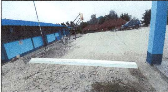
Foto 7: Reparación de cuneta de concreto, un total de 10 ML
